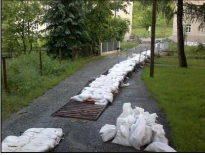
Abb. 49: Sandsackverbau an der hydraulischen Engstelle Brücke Am Kirchberg 23 bei einem Hochwasserereignis;
