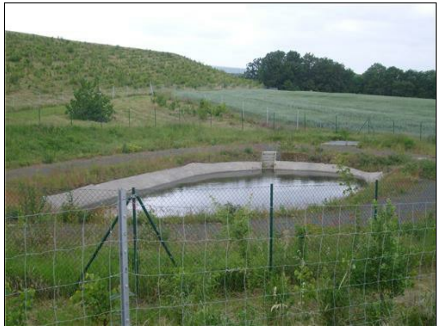
Abb. 30: Regenrückhaltebecken A17-RRB19 mit Einleitung in die Talsperre Kauscha; 03.06.2009
