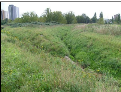
Abb. 7: Einmündung des Prohliser Landgrabens in den Niedersedlitzer Flutgraben (von links) unterstrom der Pirnaer Landstraße; 18.09.2008
