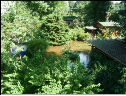
Abb. 43: Überflutete Kleingartenanlage am Unterlauf der Prießnitz; 16.08.2010
