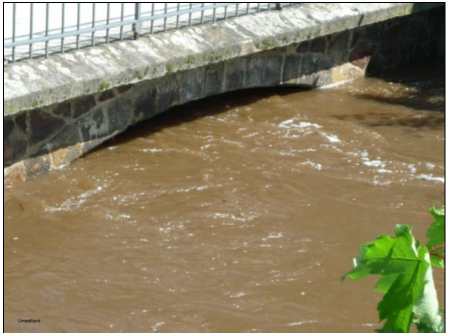
Abb. 45: Brücke Nordstraße beim Hochwasser im August 2010; 16.08.2010
