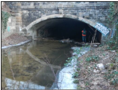
Abb. 10: Gewölbe stromauf Bautzner Str.; 06.12.2018
