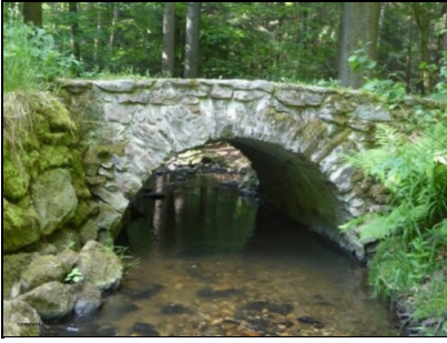
Abb. 36: Gewölbebrücke am Nachtflügelweg, Blick stromab; 04.07.2015
