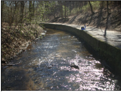
Abb. 18: Gewässerabschnitt am Prießnitzgrundweg mit Ufermauer, geringer Sandanteil Frühjahr 2014; 20.03.2014
