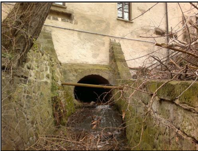
Abb. 6: Helfenberger Bach in Niederpoyritz, Auslauf aus Verrohrung an der Eugen-Dieterich-Straße, Blick stromauf; 11.04.2012
