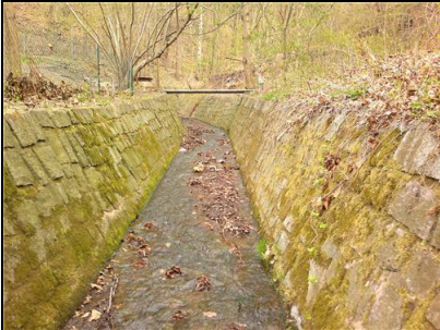
Abb. 23: Massiv mit Mauern befestigter Gewässerabschnitt in Niederpoyritz; 11.04.2012
