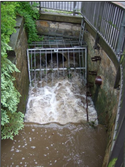
Abb. 24: Treibgutfang RFT072 am Einlauf in die Verrohrung Staffelsteinstraße/ Pillnitzer Landstraße, Blick stromab; 03.06.2013
