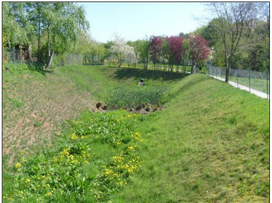
Abb. 28: Regenrückhaltebecken 35D160 am Ahornbach; 21.04.2009
