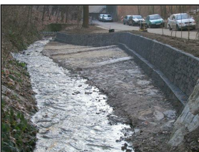
Abb. 25: Geschiebefang RFG005 nördlich der Bebauung Helfenberger Grund 8 a bis i; 05.01.2005
