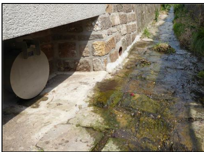
Abb. 29: Regenwassereinleitung Plantagenweg, Blick stromauf; 19.06.2019
