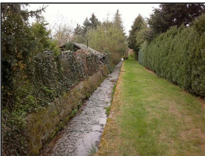
Abb. 7: Helfenberger Bach im Bereich von Kleingärten in Niederpoyritz unterhalb Pillnitzer Landstraße, Blick stromab; 11.04.2012
