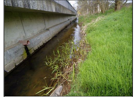
Abb. 18: Schullwitzbach, Gewässergüte-Messstelle des Umweltamtes swb4 Ortsausgang Eschdorf, Blick stromauf; 19.04.2016
