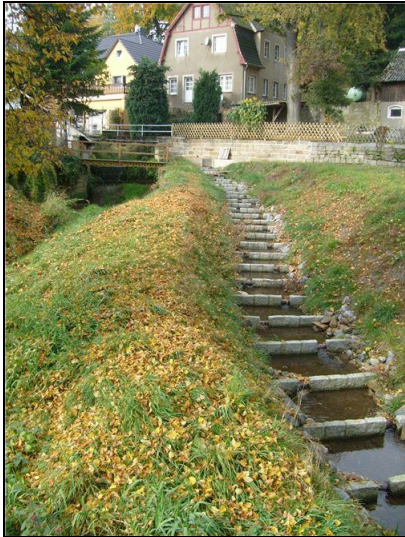
Abb. 29: Absturz, Umgehungsgerinne LDG001 mit Fischaufstiegsanlage und Wehr BRZ003 im Bereich Eschdorfer Teich; 17.10.2008
