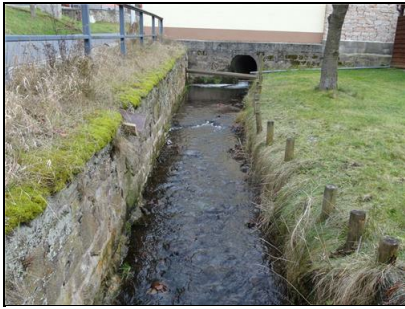
Abb. 5: Schullwitzbach in der Ortslage Schullwitz unterhalb vom Mühlteich, Blick stromab; 30.01.2018
