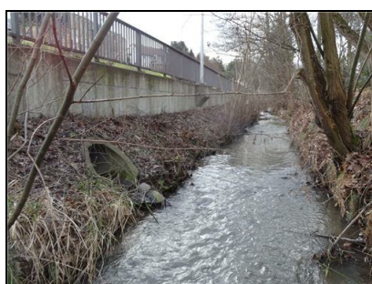
Abb. 33: Straßenentwässerungs-Einleitstelle 140B16; 30.01.2018
