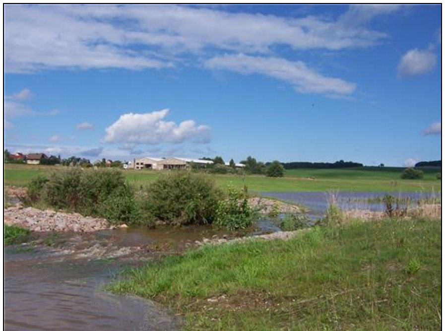
Abb. 30: HWRB Schullwitzbach, eingestaute Flutmulden; 16.08.2010
