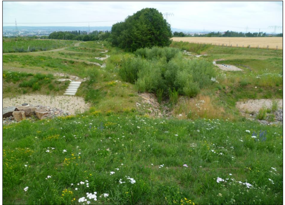
Abb. 2: Offengelegter Weidigtbach östlich Ockerwitzer Allee, links und rechts des Gewässers naturnahe Rückhalte mulden, 10.04.2012
