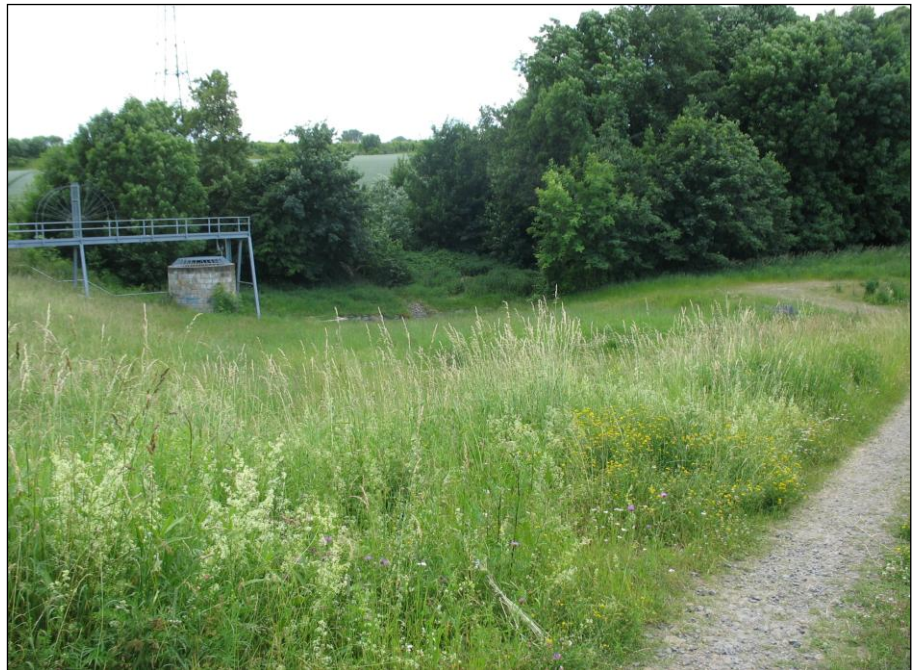
Abb. 15: Hochwasserrückhaltebecken Gorbitzbach 2, Beckenraum
