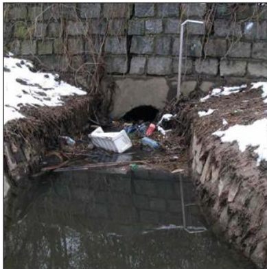
Abb. 32: Mündung Weidigtbach, Einlauf Verrohrung
