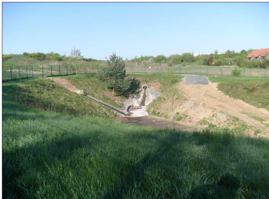
Abb. 16: Regenrückhaltebecken 45D83 Gorbitzbach Altfranken, Otto-Harzer- Straße
