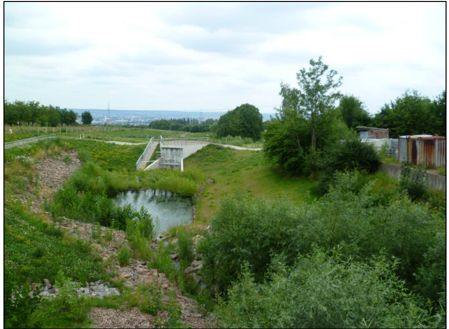
Abb. 14: Teil des Hochwasserrückhaltebeckens Flutmulden Weidigtbach, kleines Rückhaltebecken (Speicherraum 3000 m 3 ) unterhalb Ockerwitzer Allee, 03.07.2012
