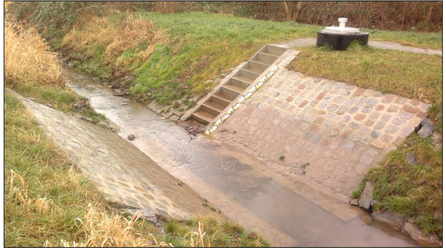
Abb. 22: Pegel PLG1 unterstrom Pirnaer Landstraße
