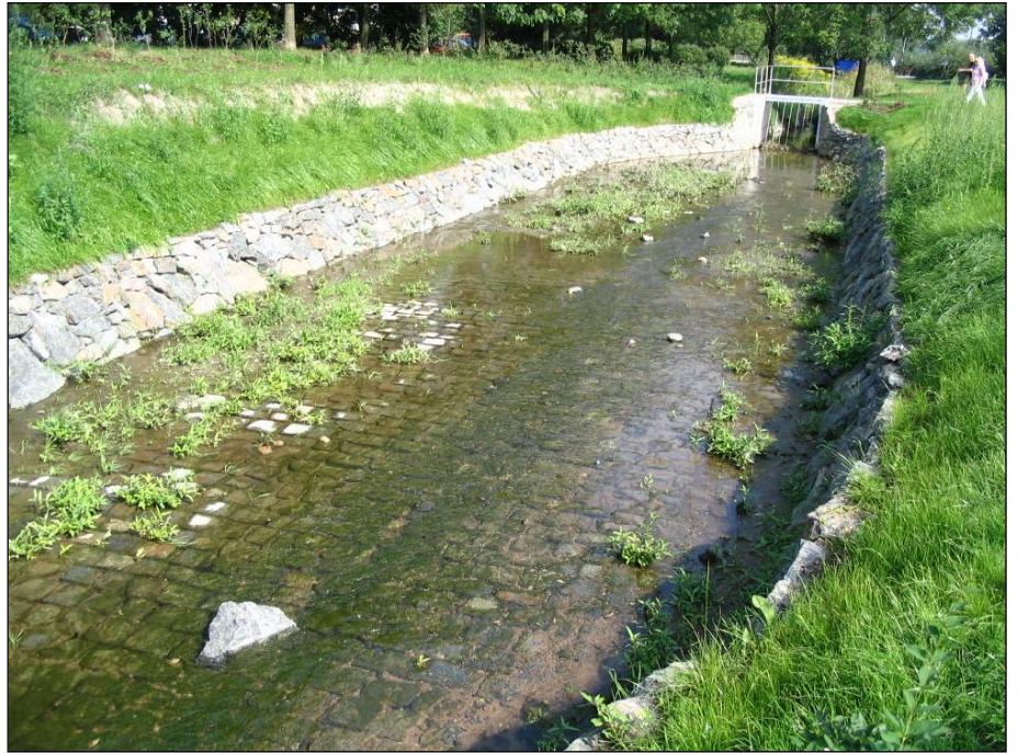
Abb. 20: Sedimentfang SF_LE_02 Gamigstraße Höhe 120. Grundschule
