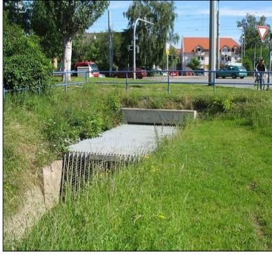
Abb. 8: Prohliser Landgraben, Einlauf in die Verrohrung Mügelner Straße
