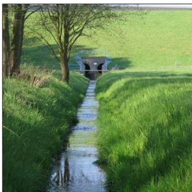
Abb. 3: Geberbach unterhalb der Talsperre Kauscha
