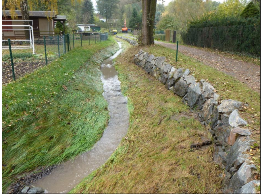
Abb. 30: Ertüchtigter Geberbach an Kleingartenanlage unterstrom Talsperre Kauscha, 27.10.2011; der durch die Ablassprobe verursachte Höchstwasserstand ist am umgelegten Gras erkennbar
