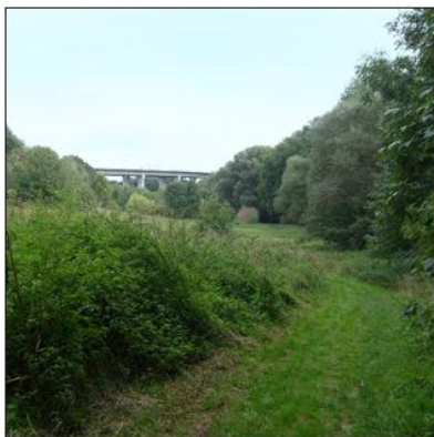
Abb. 2: Gebergrund, im Hintergrund Brücke der Autobahn BAB 17
