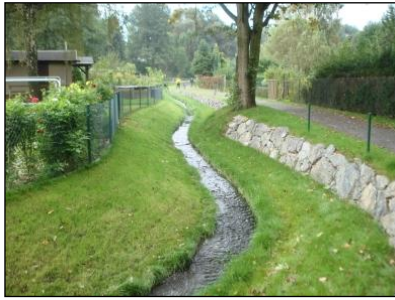
Abb. 13: Messstelle des Umweltamtes am Geberbach (Brücke Kauscha, Am Stausee)
