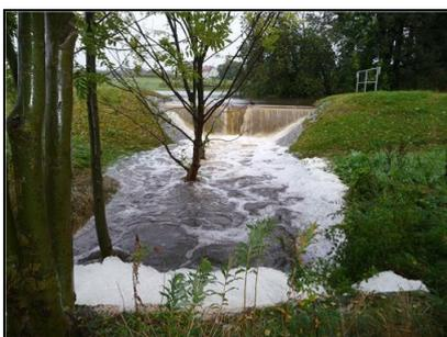
Abb. 37: Hochwasser 2010, überlaufendes Hochwasserrückhaltebecken Forellenbach; 28.09.2010
