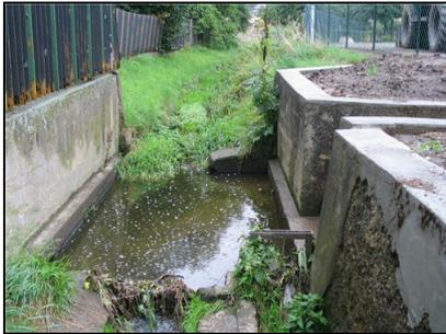
Abb. 31: Sedimentfang RFS022;
