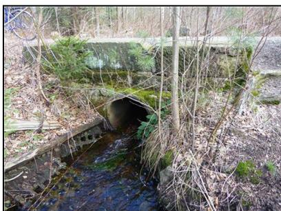
Abb. 25: Sandsteinquaderdurchlass mit Rohr am Sternbrückenhügelweg; 02.03.2020
