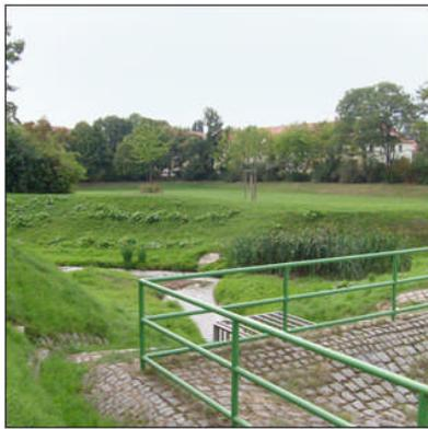
Abb. 6: Hochwasserrückhaltebecken Hugo-Bürkner-Park in Strehlen, im Vordergrund das Überlaufbauwerk
