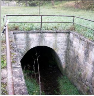
Abb. 7: Einlauf in Verrohrung oberhalb Am Kirchberg
