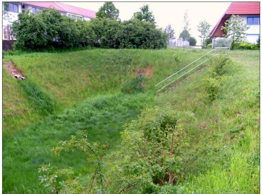
Abb. 21: Regenrückhaltebecken 47S64 am Merbitzer Graben (Stauvolumen 493 m 3 )
