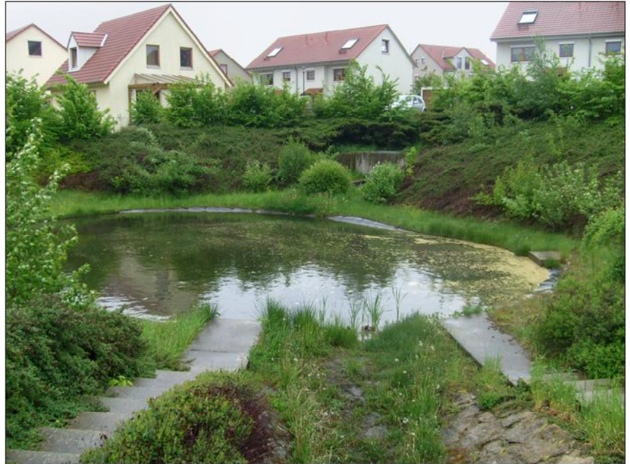
Abb. 20: Regenrückhaltebecken 46W187, Gompitzer Hang am Schmiedeberggraben (Stauvolumen 414 m 3 )
