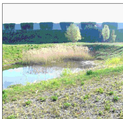
Abb. 19: Regenrückhaltebecken A17-RRB04 am Zschonerbach
