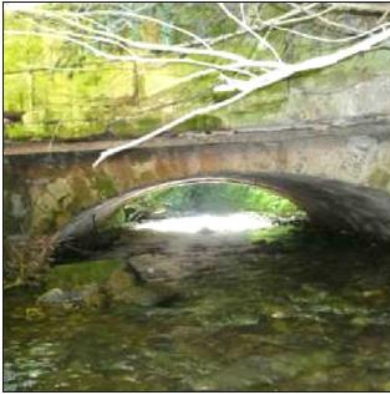
Abb. 29: Brücke im Bereich „Am Kirchberg 23“
