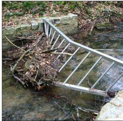
Abb. 14, 15: Treibgutfang TF_RE_12 (links) und Geschiebefang GF_RE_01 (rechts) im Wachwitzbach südöstlich Pappritzmühle
