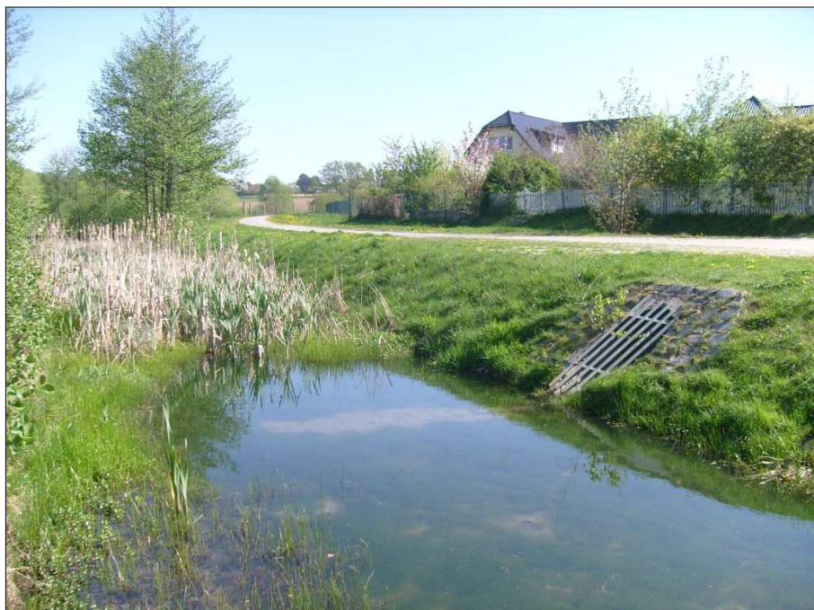
Abb. 13: Regenrückhaltebecken 34T104 am Wachwitzbach, Zachengrundring 94 (Stauvolumen: 1 485 m³)
