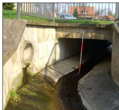
In den Schullwitzbach münden oben genannte Auslässe des Kanalnetzes der Stadtentwässerung Dresden GmbH (Regenwassereinleitungen) mit einer Nennweite gleich und größer 300 mm.
