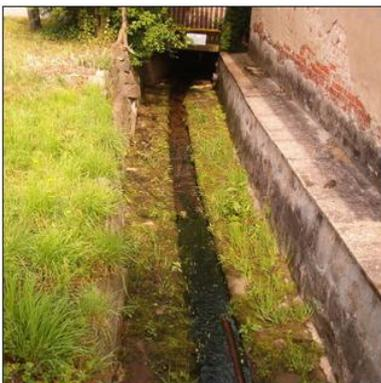
Abb. 9: Kanalartig ausgebauter Abschnitt des Weißiger Dorfbaches in der Ortslage Weißig
