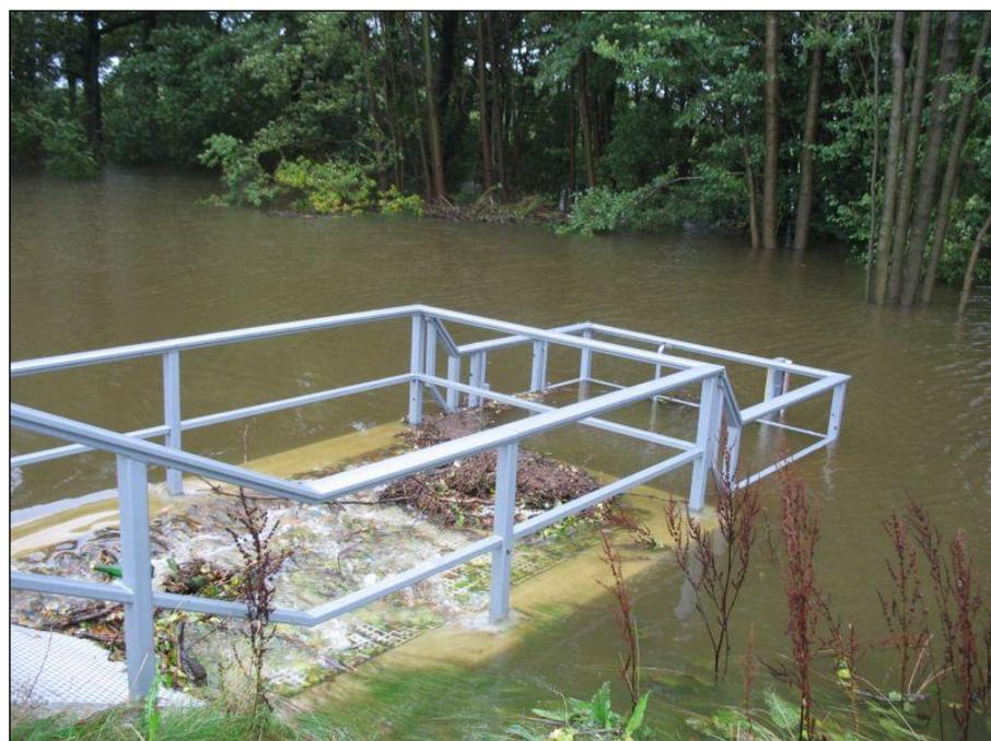
Im Stadtgebiet von Dresden treten Hochwasserprobleme am Oberlauf der Bartlake in der Ortslage Wilschdorf auf. Hier hat die Bartlake aufgrund zahlreicher zu gering dimensionierter Durchlässe und schadhafter Verrohrungen eine sehr geringe Leistungsfähigkeit. Schon ab HQ1 kommt es zu Ausuferungen.
