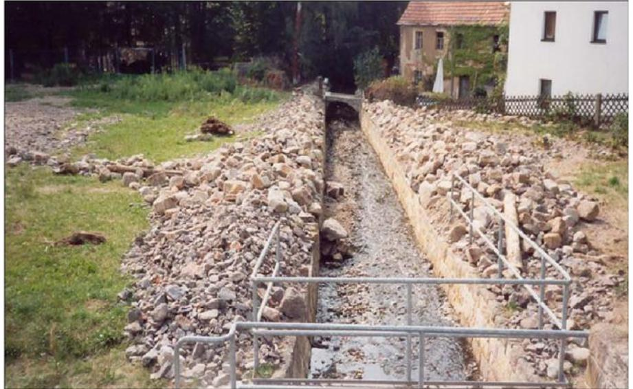
Durch den Bau zweier Geschiebefänge an Friedrichsgrundbach und Malschendorfer Graben nach dem Hochwasserereignis 2002 ist die Geschiebeführung bei Hochwasser im Unterlauf des Friedrichsgrundbaches inzwischen deutlich reduziert.
