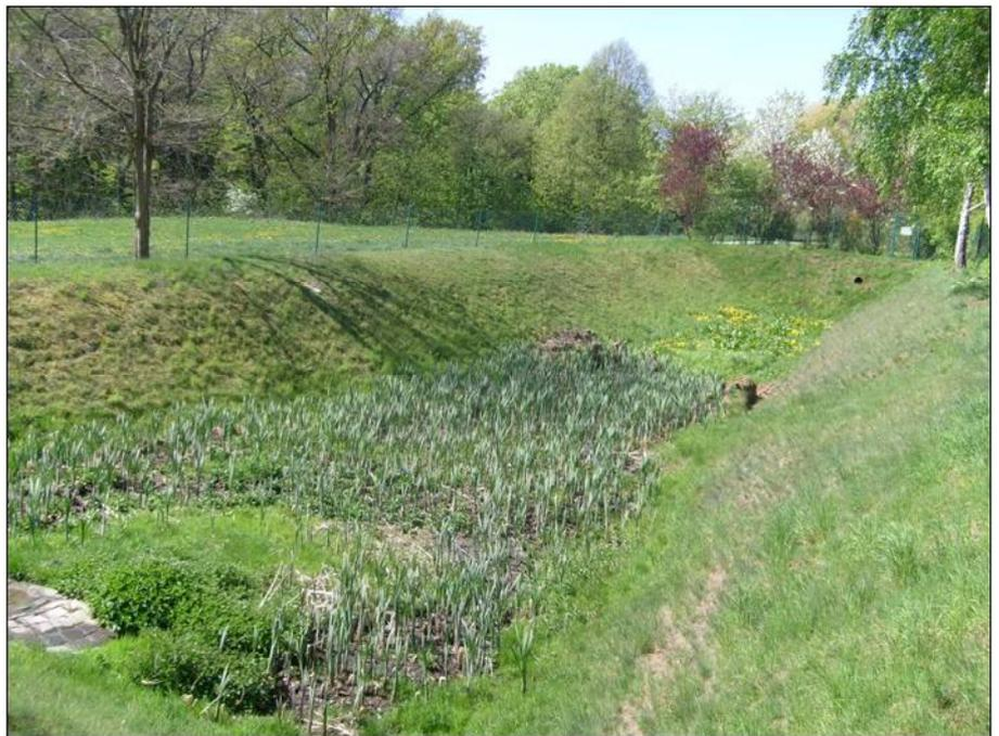
Die Regenrückhaltebecken wurden im Zusammenhang mit der Erschließung neuer Baugebiete in Pappritz errichtet. Durch den geschaffenen Rückhalteraum erfolgt eine Drosselung der angeschlossenen Flächen auf die natürliche Abflussmenge (unversiegelte Fläche) in die Vorfluter.
