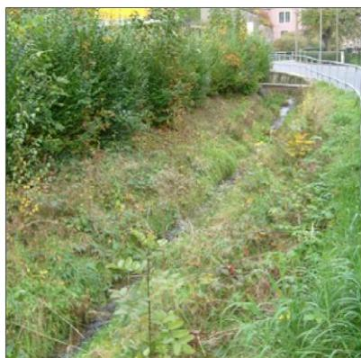
Nach dem Hochwasser im Jahre 2002 erfolgte auf Grund der Schäden im Bereich Helfenberger Grund 8b (ehemalige Möbelfabrik) eine Offen- und Umverlegung des Gewässers auf einer Länge von etwa 185 Metern.
